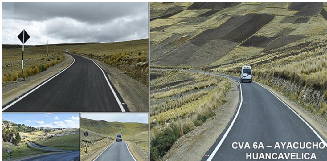
Foto: Provías Descentralizado
