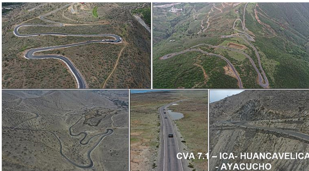
Foto: Provías Descentralizado
