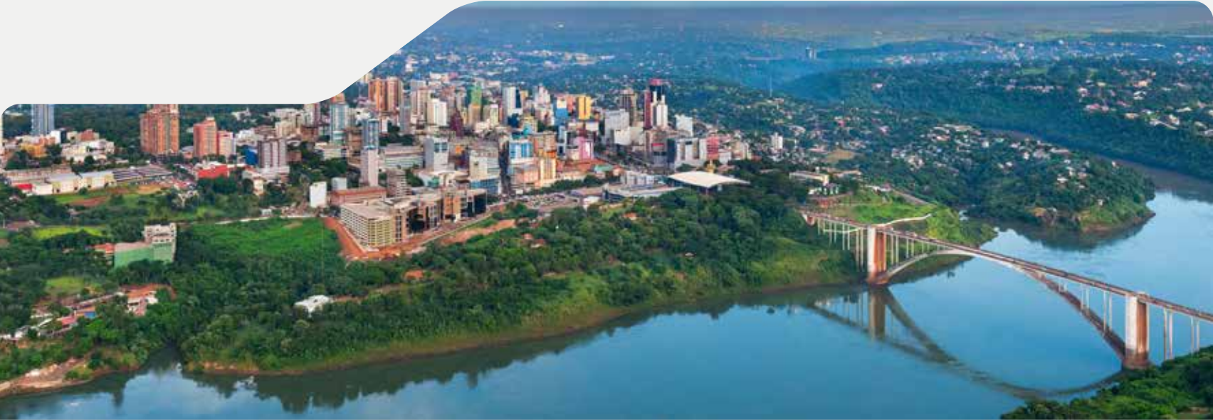
Vista aérea da Cidade do Leste e da Ponte da Amizade, que liga o Paraguai e o Brasil.
