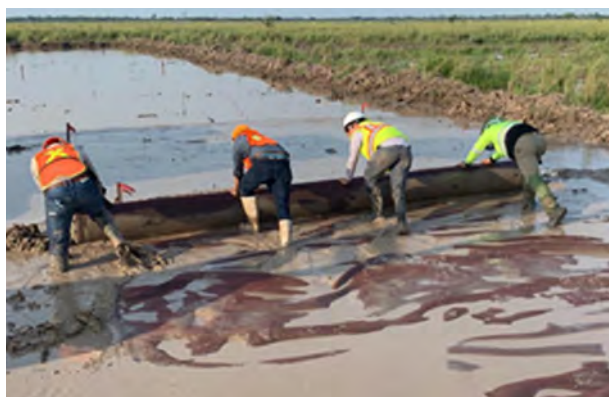
FIGURA 16. COLOCACIÓN Y TRASLAPE DE GEOSINTETICO
