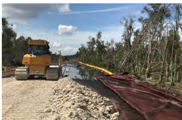
ILUSTRACIÓN 14. COLOCACIÓN Y DISTRIBUCIÓN DE CAPA GRANULAR SOBRE GEOSINTÉTICO
