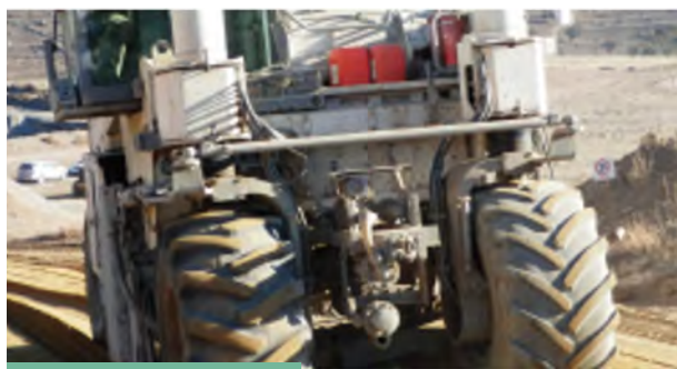
III. La máquina estabilizadora realiza la mezcla del suelo con el conglomerante.
