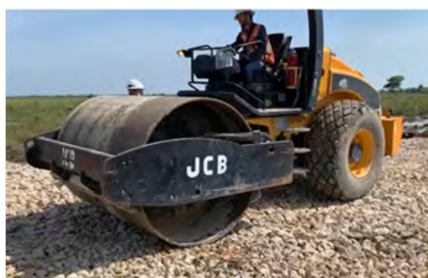
FIGURA 17. BANDEO DE MATERIAL GRANULAR CON RODILLO COMPACTADOR
