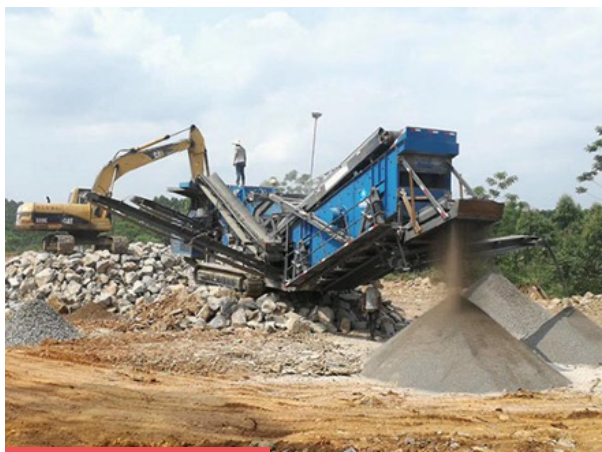
Ilustración 5. Trituradora de materiales pétreos instalada en campo.
