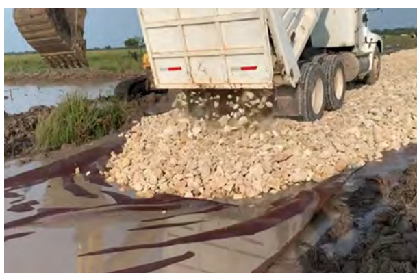
ILUSTRACIÓN 14. COLOCACIÓN Y DISTRIBUCIÓN DE CAPA GRANULAR SOBRE GEOSINTÉTICO
