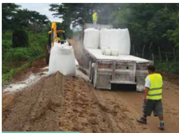
Ilustración 9. Material escarificado y encamado para dosificación de óxido de calcio.
