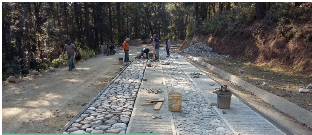
Ilustración 8. Empedrado a base de piedra en construcción de caminos tipo huella-placa
