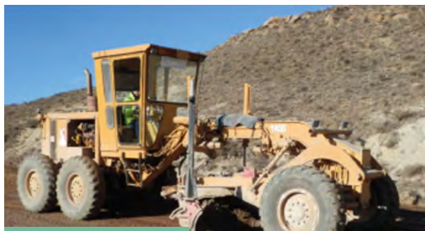
I. Nivelación y perfilado del camino y sus cunetas.
