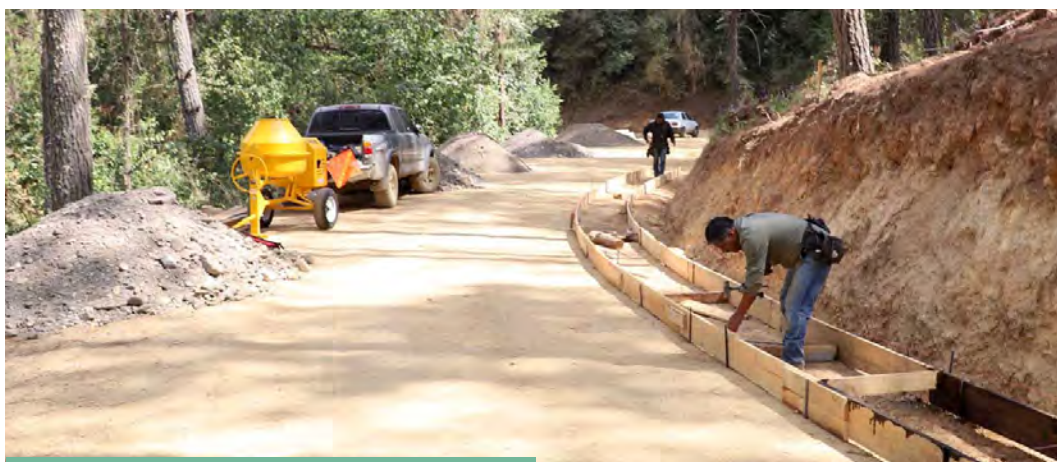
Ilustración 6. Colocación de cimbra de madera en tramo en curva para colado de roderas de concreto hidráulico
