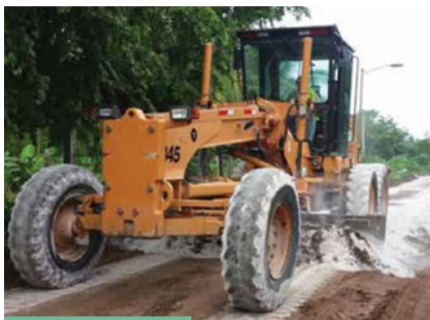
Ilustración 11. Homogeneización de arcilla con óxido de calcio.
