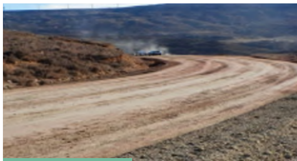
V. Estado de la pista estabilizada y compactada.
