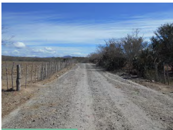
Ilustración 12. Aspecto físico de capa estabilizada con óxido de calcio, en Municipio Tomatlán en el Estado de Jalisco, México.
