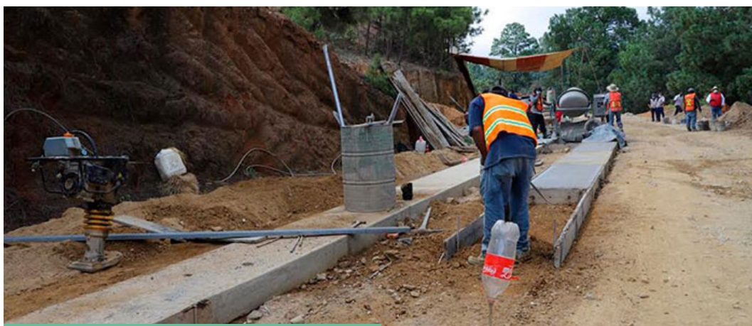
Ilustración 7. Colado de roderas de concreto hidráulico
