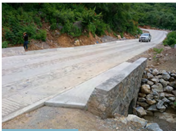
Ilustración 3. Solución de pavimentación empleada para el PPCCM, Santiago de Atitlán, Estado de Oaxaca, México.
