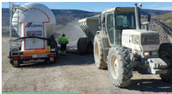
II. Carga del cemento en la tolva que lo distribuye y dosifica sobre la traza del camino.
