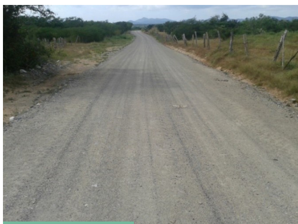
Ilustración 10. Formación de capa estabilizada con óxido de calcio, en Municipio Tomatlán en el Estado de Jalisco, México.
