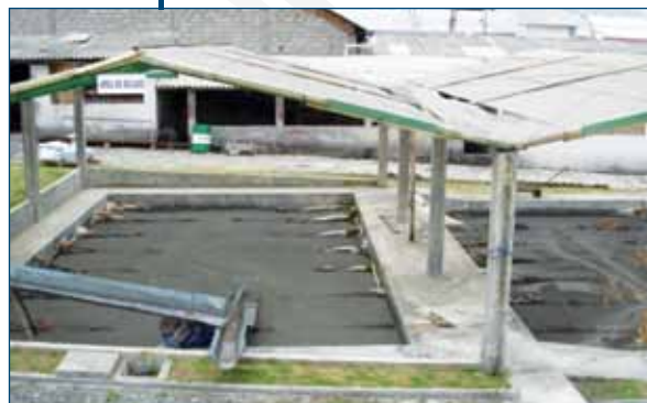
Área de secado de lodos
