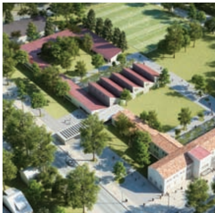
PROYECTO de la Escuela Técnica N° 3 Ingeniero Santiago Maradona, en Santiago del Estero.
