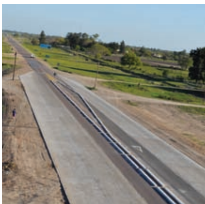
NUEVO PAVIMENTO urbano en Chaco.
