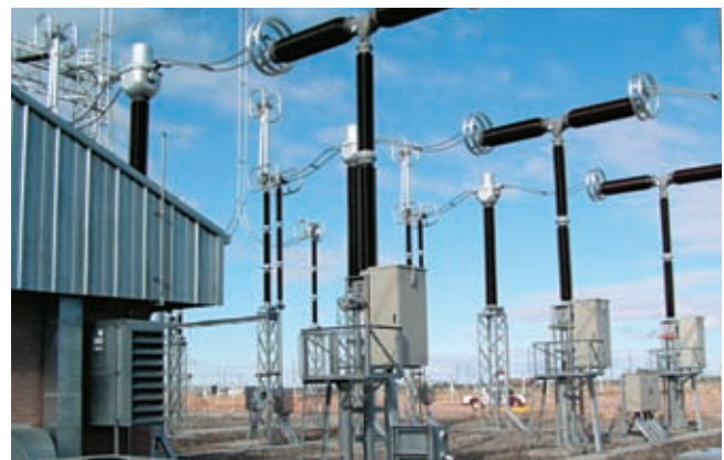
LA OBRA conecta a la región Patagónica con el Sistema Argentino de Interconexión.
