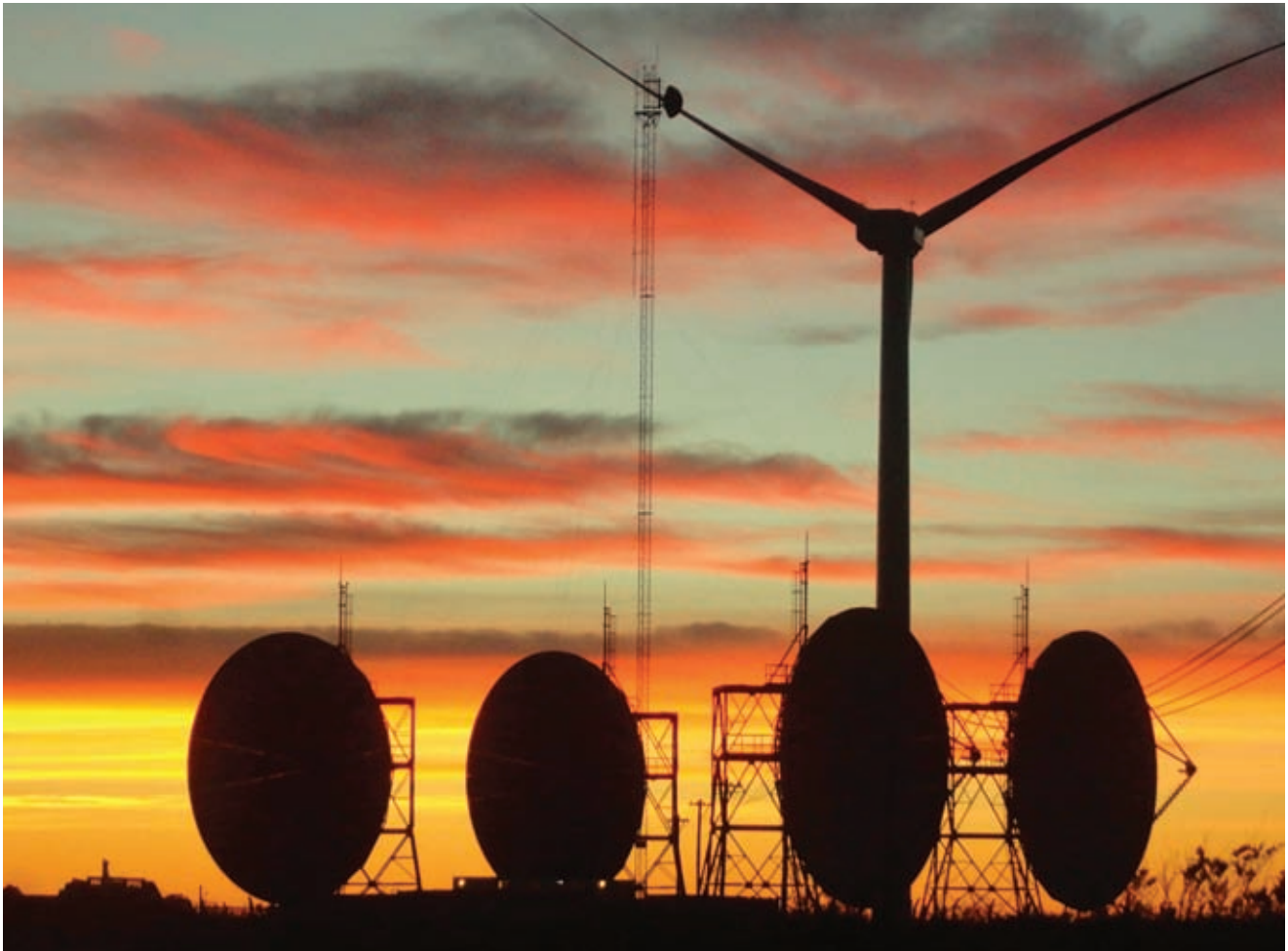
LOMA BLANCA es uno de los proyectos más importantes de generación de energía eólica en Sudamérica.
