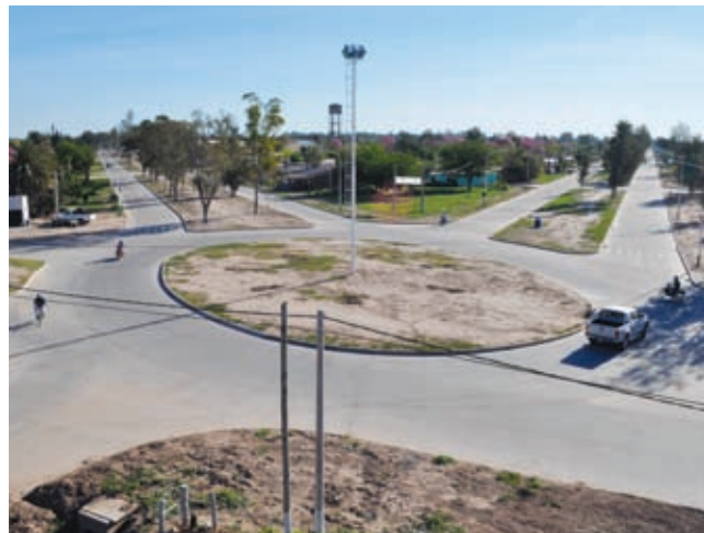
ANTES Y DESPUÉS de las obras realizadas. Rotonda sobre Av. Kennedy, Villa Ángela, Chaco.
