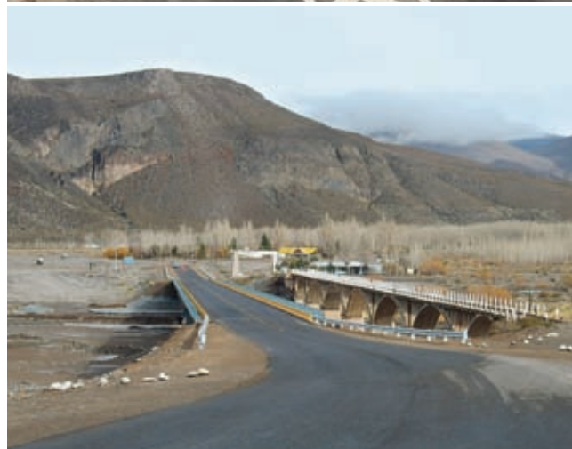
1. ALTEO DE LA RUTA NACIONAL N° 7, inundada durante años por la laguna 'La Picasa'.
