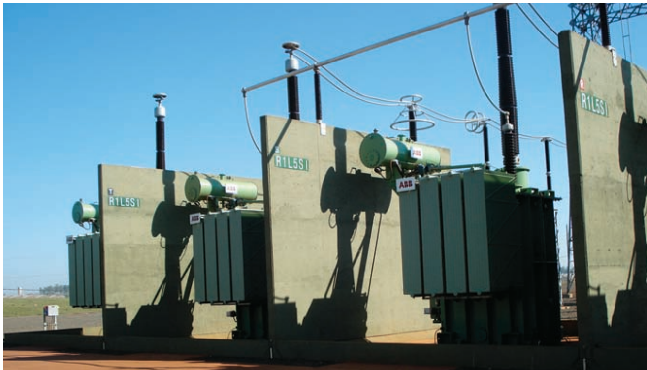
ESTA OBRA origina ahorros anuales de combustible de US$ 40 millones.
