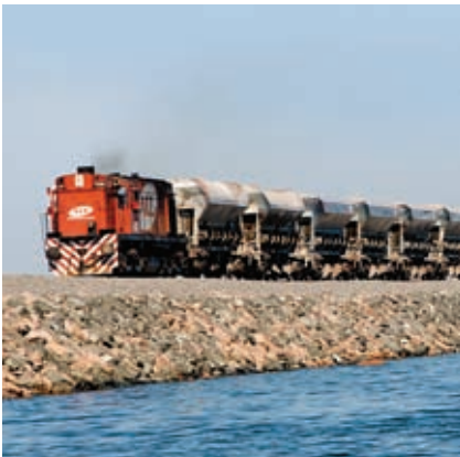
ALTEO del Ferrocarril Buenos Aires-Mendoza afectado por las inundaciones de la laguna 'La Picasa'.
