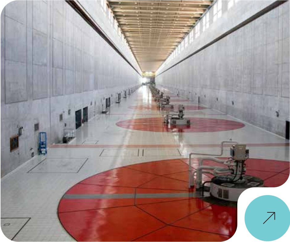
Complejo hidroeléctrico binacional Yacretá, entre Argentina y Paraguay.
